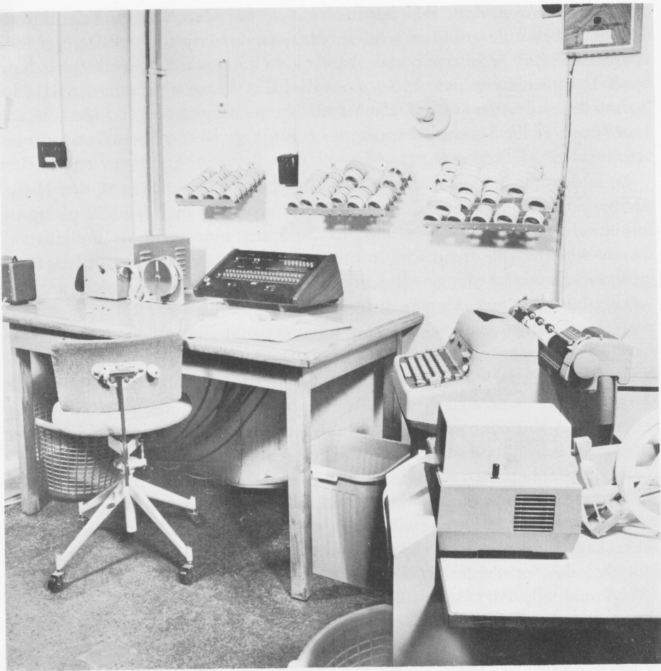
Kontrolbord, læser og outputudstyr til GIER. Interiør fra »pige-kammeret« i instituttets daværende lokaler Nr. Farimagsgade 1, hvor GIER trods de trange pladsforhold fungerede upåklageligt i hele sin funktionstid.
